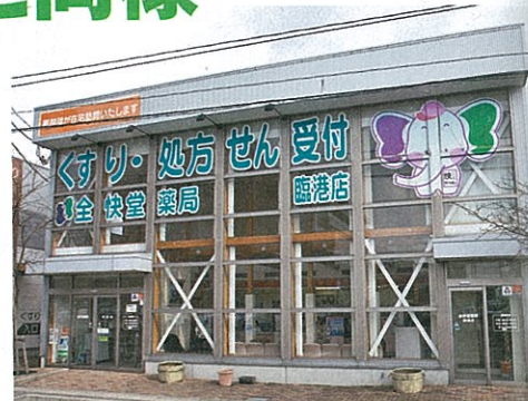
総合病院の門前に位置する全快堂薬局臨港店は、前面がガラス張りである開放的な空間が生まれている
